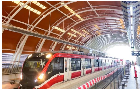
チャワン駅に停止しているLRT電車
